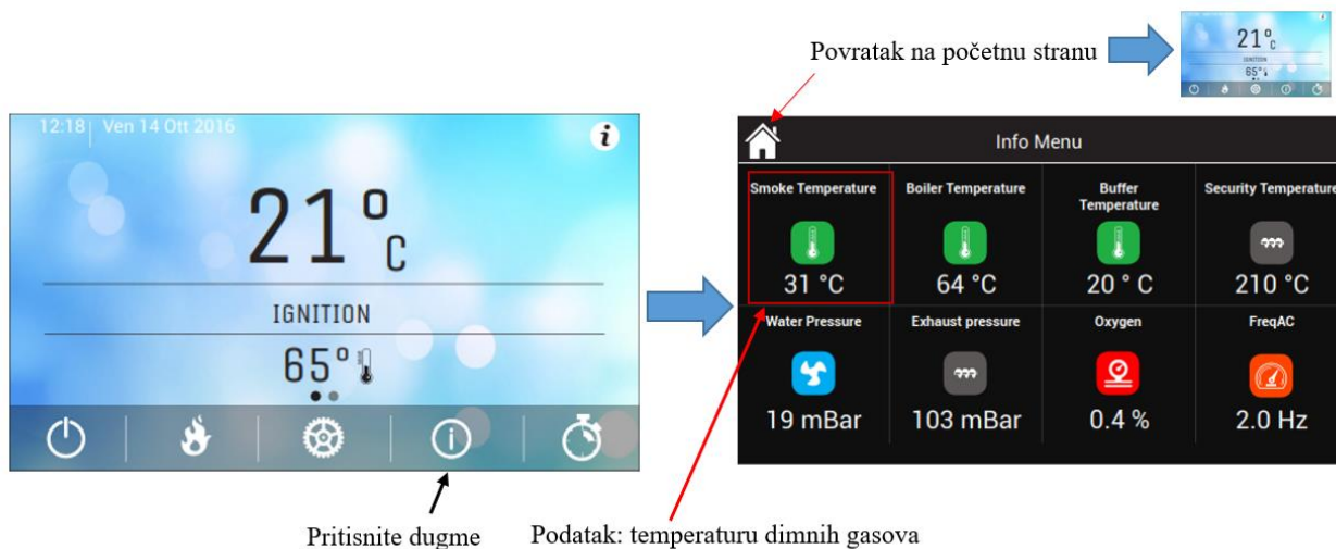
Slika 31. Odčitavanje temperature dimnih plinov
